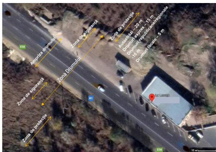
Figura nr.1 Amplasarea neautorizată a obiectivelor comerciale în zona de siguranță a drumului R1
